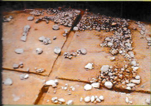
②の曲輪礎石建物 二の曲輪には複数棟の建物が存在した。そのうち南端一棟は礎石を利用した丈夫な構造の建物跡。
